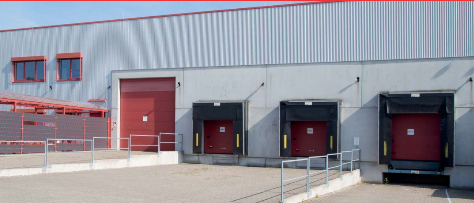
Éclairage extérieur – zone extérieure - zone d'entrée avec FL2N-LED
